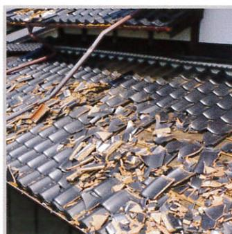
脱落した瓦による二次被害
