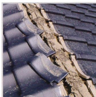
半端瓦の無緊結による脱落
